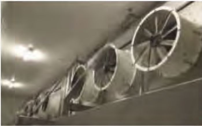
รูปที่ 7 แสดงตัวอย่างการติดตั้งพัดลมและทิศทางลมที่หมุนเวียนภายในห้อง
